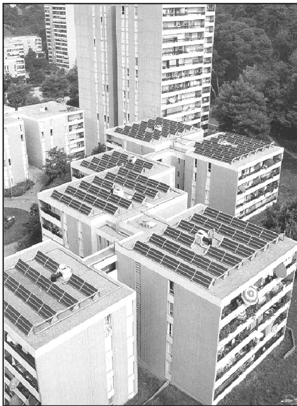
Colectores fototérmicos en una urbanización en Cannes, Francia (cortesía Thibaut-Explorer, cedida por la Embajada de Francia)
