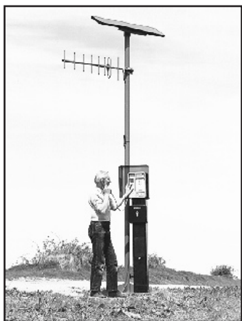
Teléfono de carretera alimentado por energía solar. (Cortesía Embajada Británica)
